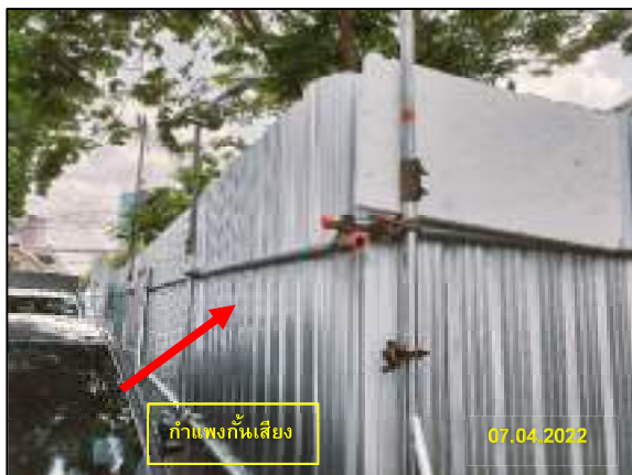
รูปที่ 2-9 การติดตั้งกำแพงกันเสียงและรั้วชั่วคราวบริเวณบ่อรับ-บ่อส่งของโครงการ
