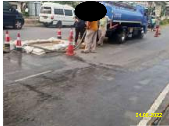
การดูดโคลนโซเดียมเบนโทไนท์ด้วยรถดูดสูญญากาศ
