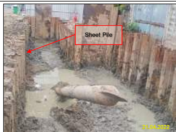
รูปที่ 2-11 การติดตั้ง Sheet Pile เพื่อป้องกันการพังทลายของดิน
