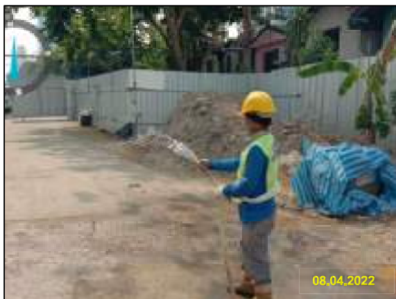
รูปที่ 2-3 การฉีดพรมน้ำเพื่อลดการฟุ้งกระจายของฝุ่นละออง
