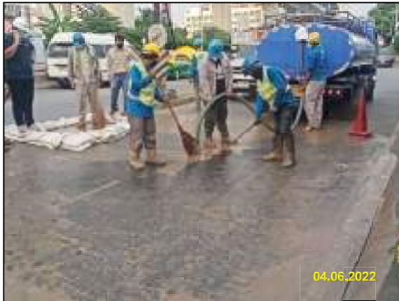
การดูดโคลนโซเดียมเบนโทไนท์ด้วยรถดูดสูญญากาศ
