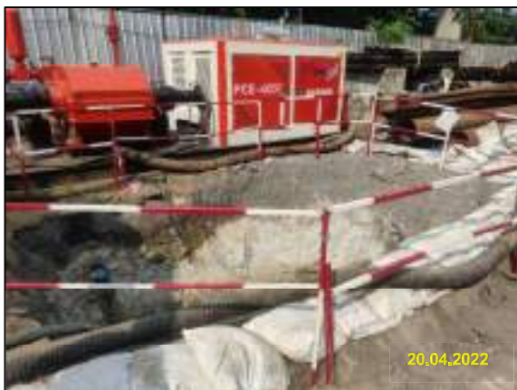
ก) จัดวางอุกทลาย และจัดทำคันดินรอบพื้นที่ป่อรับ และบ่อส่ง
