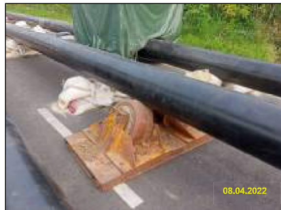
การจัดวางท่อขนส่งน้ำมันฯ และวัสดุป้องกันการพังทลาย
