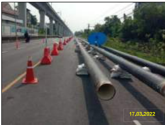
การจัดวางท่อขนส่งน้ำมันฯ และวัสดุป้องกันการพังทลาย
