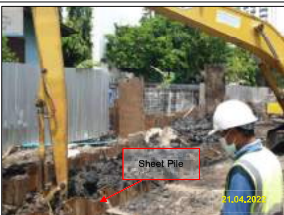
รูปที่ 2-11 การติดตั้ง Sheet Pile เพื่อป้องกันการพังทลายของดิน
